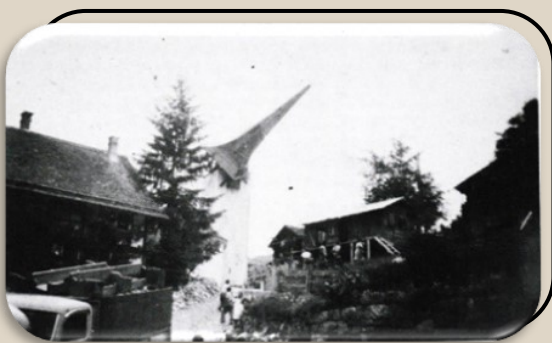
Abb. 2: Der Turm stürzt ein.
